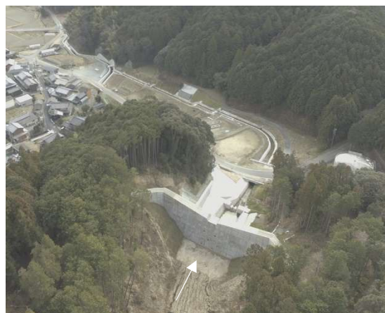
図 2-3 長谷砂防堰堤（平成 30 年（2018 年））
