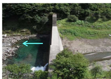
蓮貯砂ダム（堆積前）
