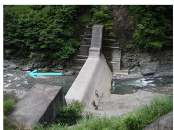
青田貯砂ダム（堆積前）
