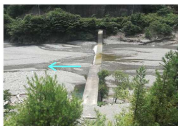
蓮貯砂ダム（堆積後）
