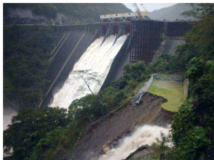
宮川ダムの放流状況
