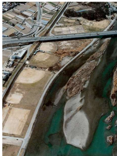
宮川大橋付近のグラウンド
