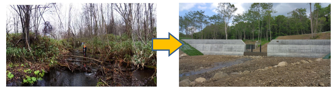
整備前 整備後 ・局地的豪雨により溪岸侵食の発生・溪畔林が傾倒し、下流への土砂流出・流木被害を与える恐れがある。 ・流木危険木を除去するとともに、安定した溪床勾配へ導くことで山脚を固定して、縦横侵食の拡大並びに不安定土砂の移動防止を図る。
