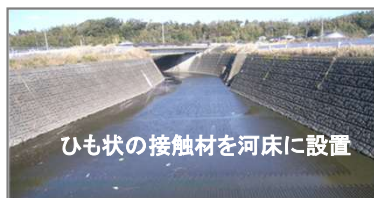
簡易な浄化施設(5号排水路)
