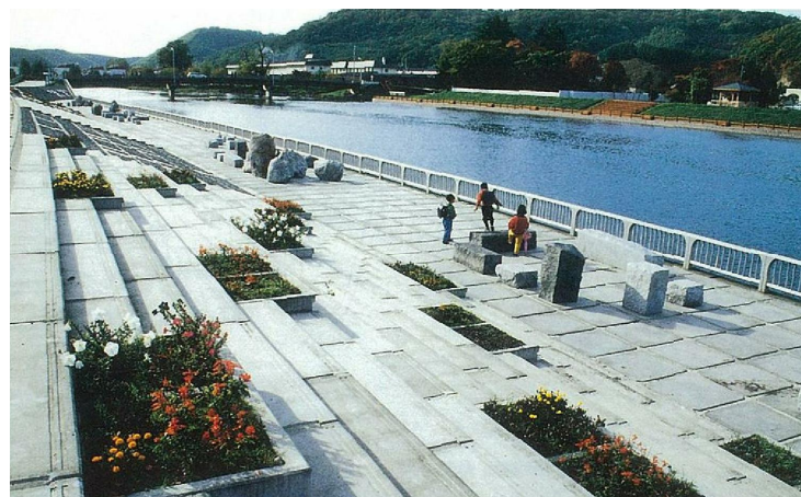
写真 4.1 景観に考慮した護岸（下流部）
