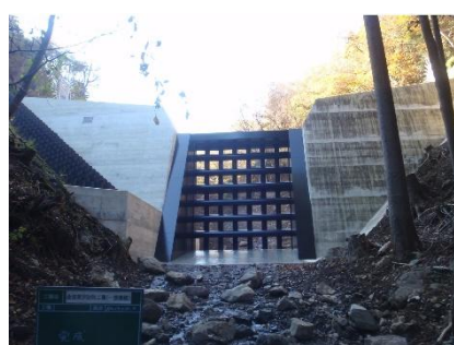
相模川水系 金波美沢砂防堰堤 [透過型砂防堰堤, R4 完成]
