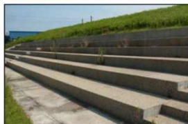
高水護岸(階段護岸)
