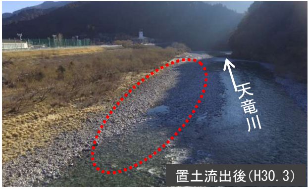
置土流出状況 (65.0k付近、約1万 \text{m}^3 )
