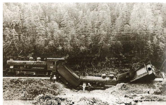
破堤し道床が流出したため、脱線した機関車 (常陸大宮市山方)
