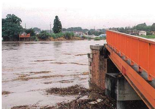
▲洪水によって流された寿橋（水戸市）
