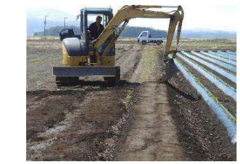
バックホウによる畦畔の高上げ
