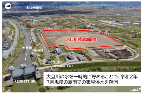
大旦川調節池 施工状況(R5.6月)
