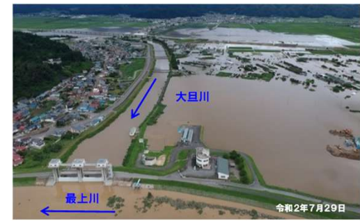
大旦川合流点 被害状況(浸水被害)
