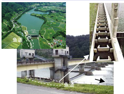
横断工作物に魚道を設置し、上下流の連続性を保全(類型1)
