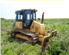
再繁茂試験施工の状況
