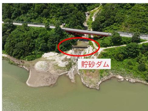
堆積土砂撤去前
