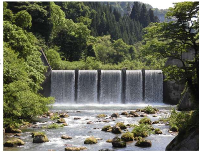
ますだま 舂玉第2砂防堰堤 (銅山川流域)
