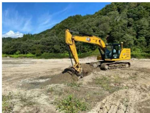
堆積土砂撤去状況
