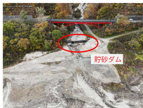
堆積土砂撤去後
