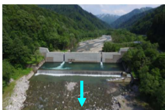
東大鳥川砂防堰堤
