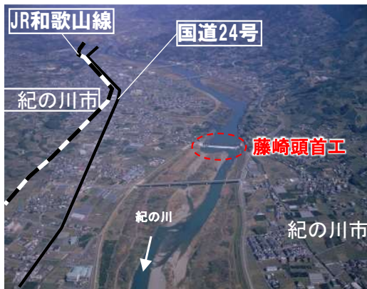
藤崎頭首工付近
