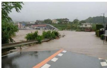
▲ 浸水状況(海南市野上中地区) (R5)
