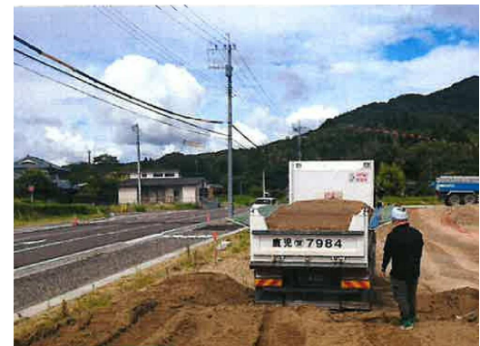
工事発生土を土地区画整理事業の盛土として活用
