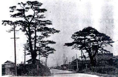
松原堤：和歌山市四箇郷付近
