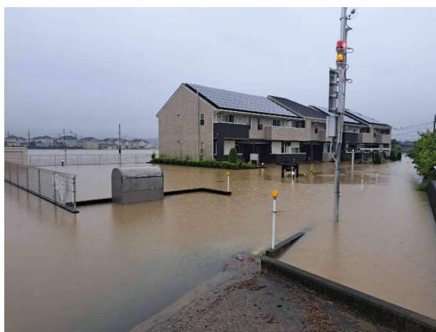
住宅浸水被害状況（紀の川市貴志川町丸栖地区）
