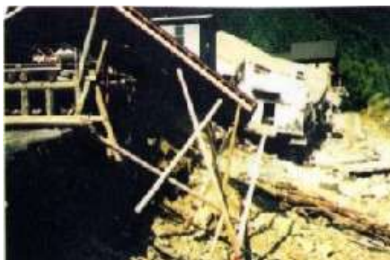
倒壊した木工センター かわかみ うのかわ (川上村東川付近)
