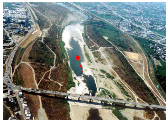
紀の川の瀬切れの状況(H6.8 船戸地点下流)
