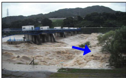
岩出頭首工での堰上げ発生の状況
