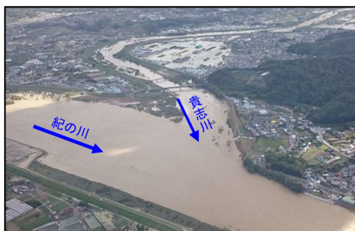
紀の川と貴志川の合流点付近の被害状況
