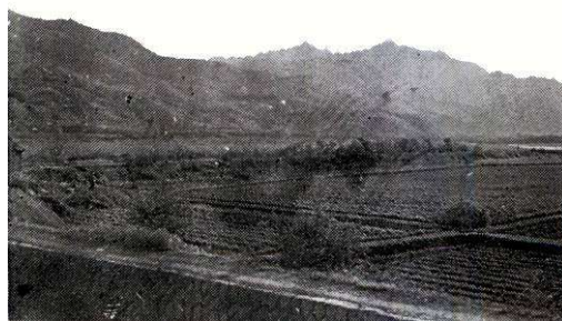
千間堤：伊都町大谷字新在家（現伊都郡かつらぎ町大谷新在家）
