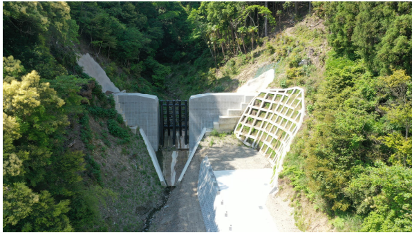
半沿川透過型砂防堰堤（紀の川市桃山町垣内） 麦谷）
