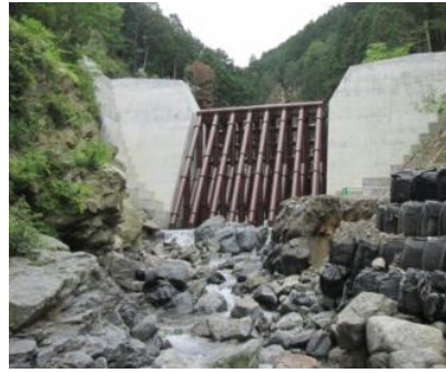
麦谷川透過型砂防堰堤（吉野郡東吉野村
