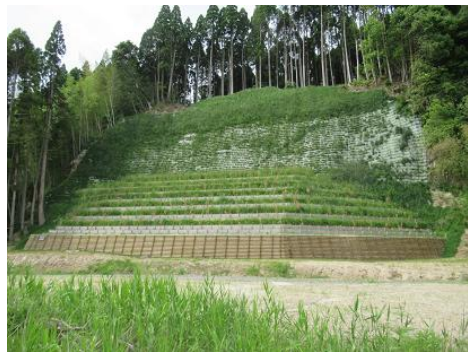
図 2-2 山腹工による土砂流出防止対策（宮崎県）
