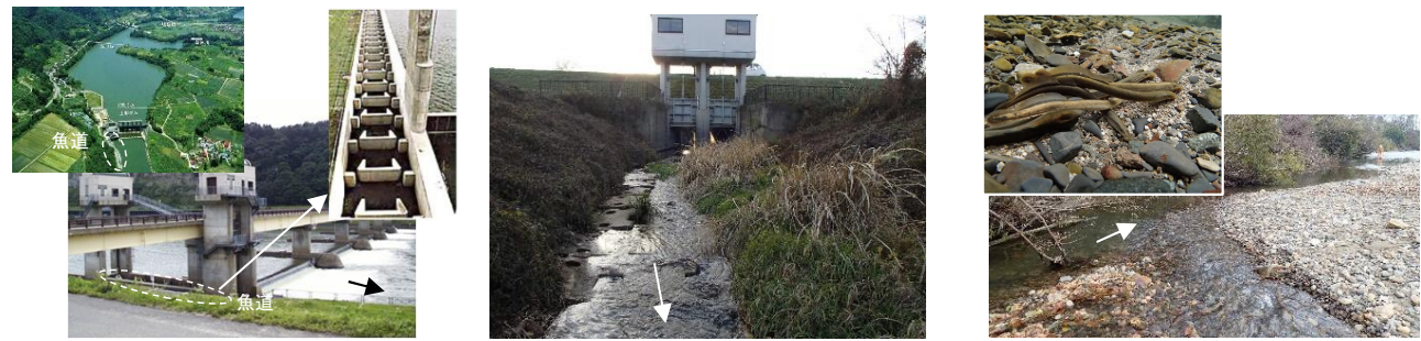
横断工作物に魚道を設置し、上下流の連続性を保全(類型1)
