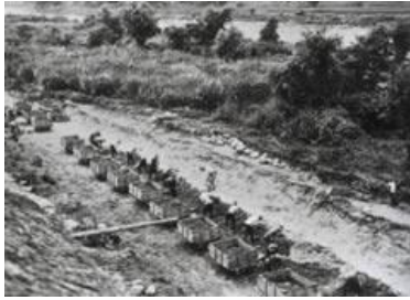
土砂運搬作業の様子(昭和8年)
