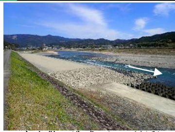
高水敷の造成 (9.2k付近)
