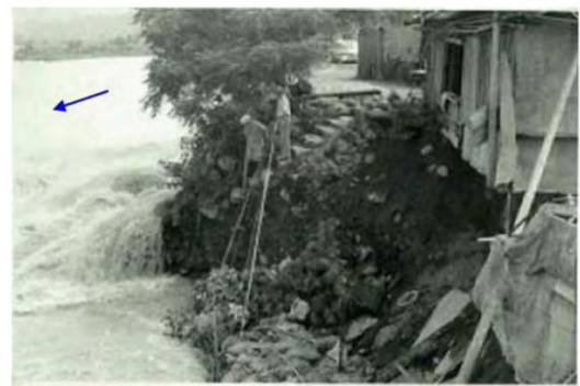
昭和45年8月洪水による下流部無堤地区の河岸侵食(香南市西佐古地先)
