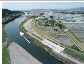
下ノ村 引堤 (8.6k付近)
