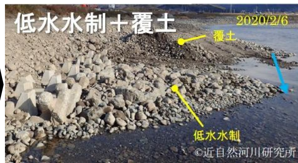
低水水制の設置状況
