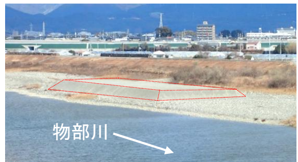
左岸1.0k地点の置土の状況(令和7年2月4日)
