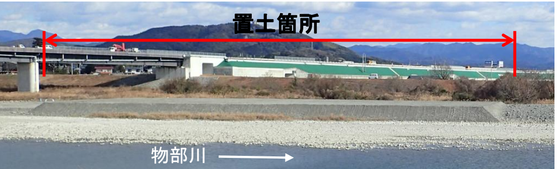
左岸2.0k地点の置土の状況(令和7年1月8日)
