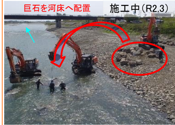
巨石の設置状況
