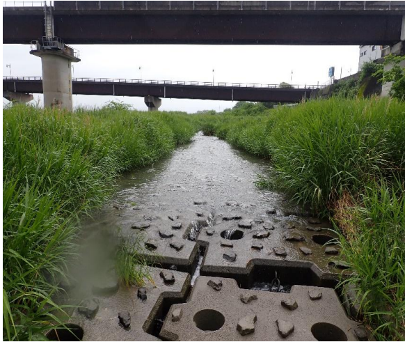
細流の状況(せせらぎ水路)
