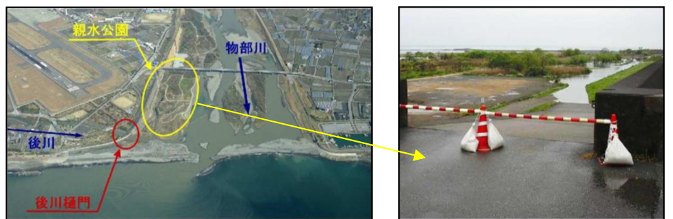
河口閉塞による親水公園の浸水状況(平成16年4月14日)
