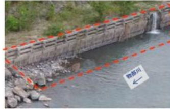
水制根固流失（箇所⑧）
