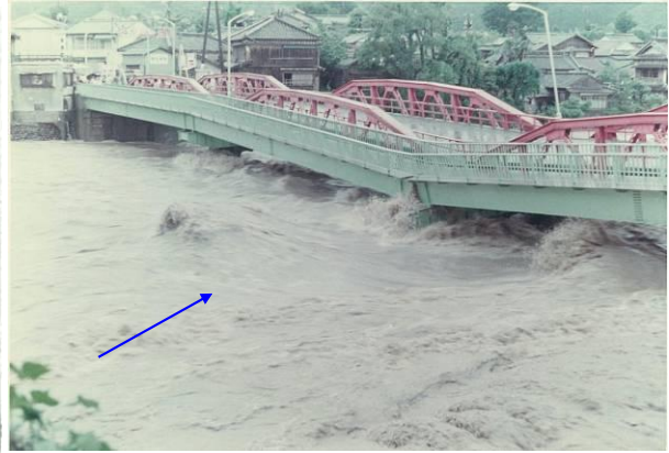
昭和47年（1972年）7月洪水での香我美橋の橋脚の被災（香美市神母ノ木地先）
