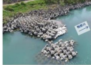
水制根固流失（箇所⑧）
