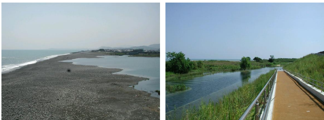
図 8-11 平成 13 年 8 月 23 日の河口閉塞による河口部右岸の親水施設の冠水状況
