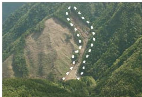
③ 別府山の崩壊状況
