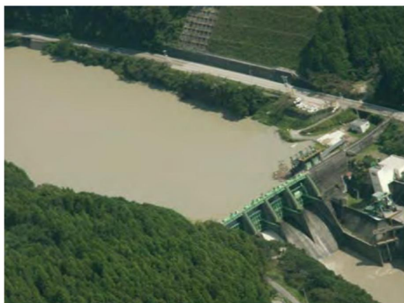
杉田ダムの濁水の状況 (平成17年9月)
