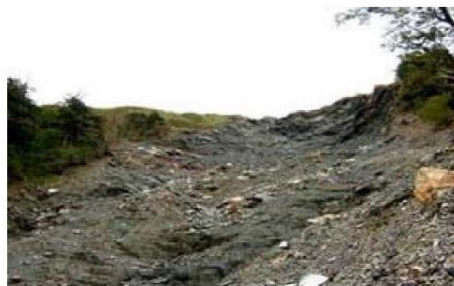
① 三嶺の崩壊状況
