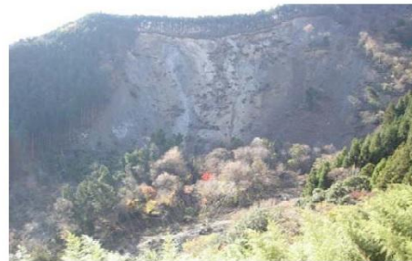
② 中尾谷の崩壊状況
