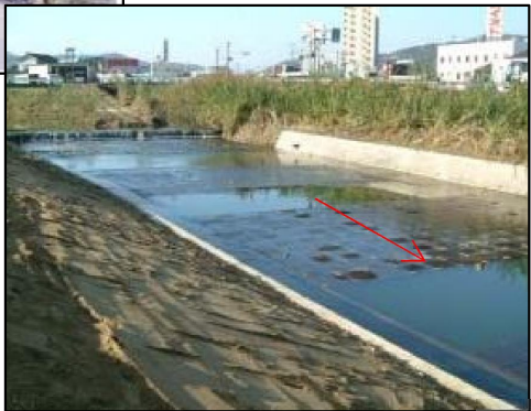
瀬戸川 接触酸化方式の河川浄化施設
