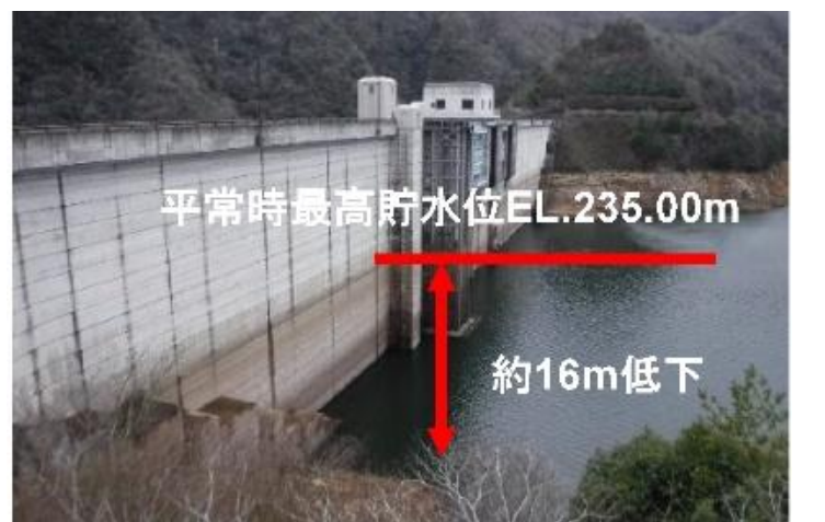
八田原ダムの渇水状況 (令和5年12月)
