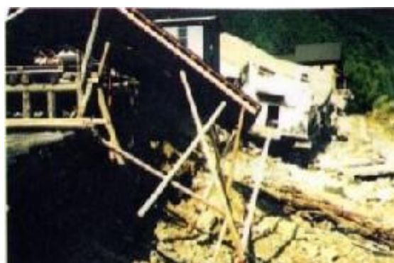
倒壊した木エセンター かわかみ うのかわ (川上村東川付近)
