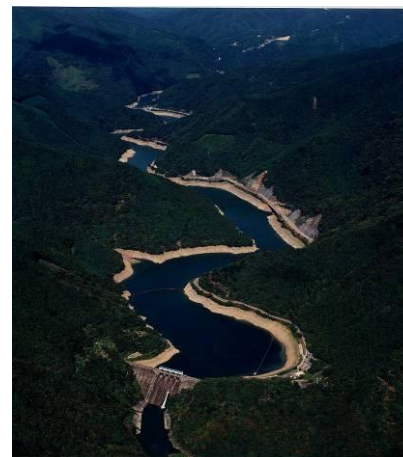
猿谷ダム渇水状況
