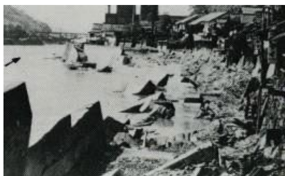
国道が流出した吉野町上市付近
