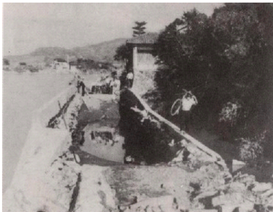
麻生津付近の被害状況 (県道海南九度山線：麻生津～竜門間)
