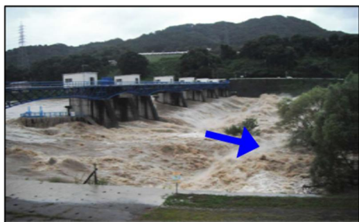
岩出頭首工での堰上げ発生の状況
