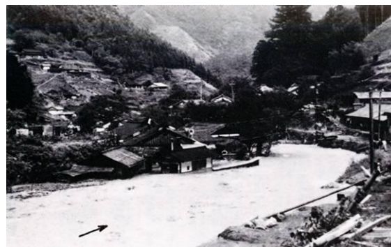
川上村西河付近の被害状況
