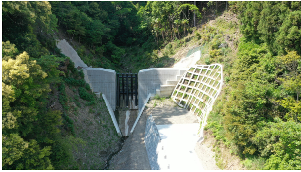
半沿川透過型砂防堰堤（紀の川市桃山町垣内）
