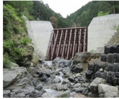
麦谷川透過型砂防堰堤（吉野郡東吉野村麦谷）
