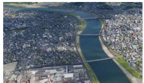
写真 4-25 薩摩川内市市街部
