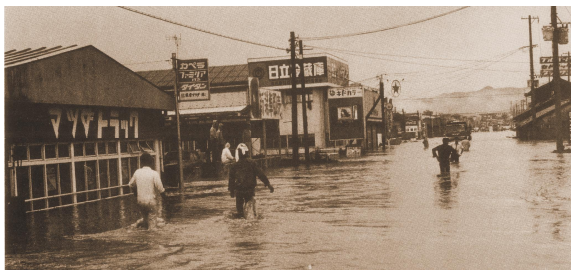
写真 4-3(1) 薩摩川内市の浸水状況 (旧川内市上川内)
