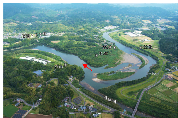
写真 2-3 (2) 樋脇川合流点付近 (21k 付近)
