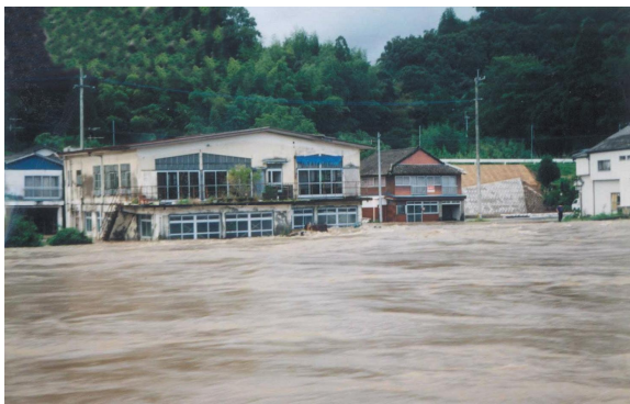
写真 4-7(4) 菱刈町浸水状況 （湯之尾地区）
