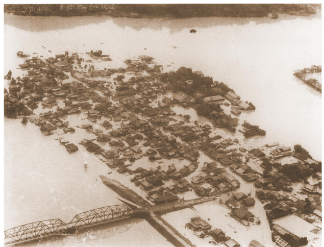
写真 4-2 薩摩川内市の浸水状況（旧東郷町）
