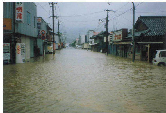
写真 4-7(3) えびの市浸水状況 （向江地区京町交差点付近）
