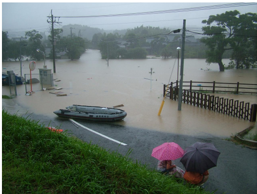
写真 4-9 (1) えびの市浸水状況
