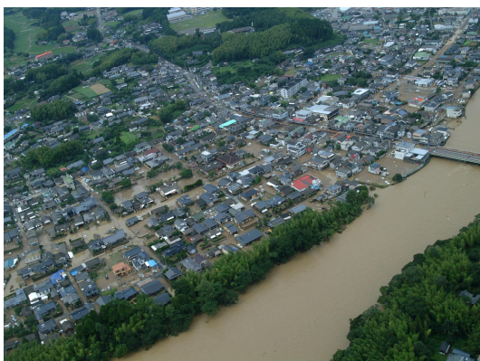
写真 4-9 (3) さつま町虎居地区浸水状況
