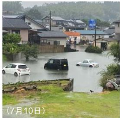
写真 4-10(2) さつま町虎居地区の浸水状況
