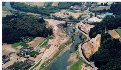
写真 4-20 轟狭窄部の開削工事 (旧栗野町)
