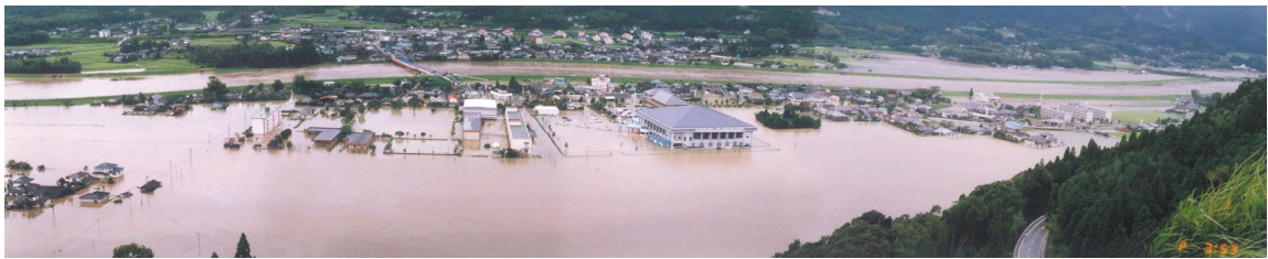
写真 4-7(1) 湧水町浸水状況（旧吉松町中心街）
