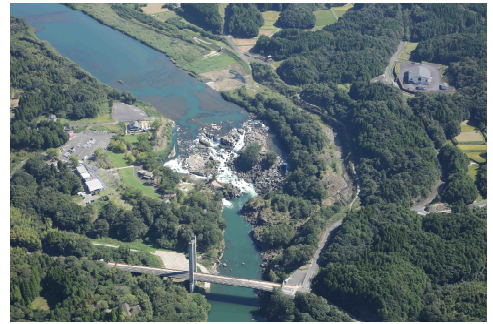
写真 4-26 曾木の滝分水路
