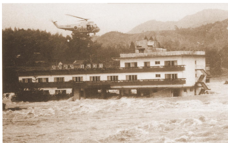
写真 4-4(1) さつま町での住民救助作業 (旧宮之城町湯田地区)
