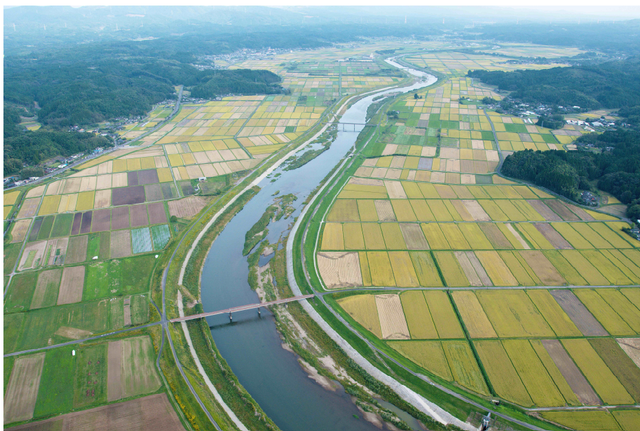
写真 8-2 川内川上流部（菱刈地区付近：70k）
