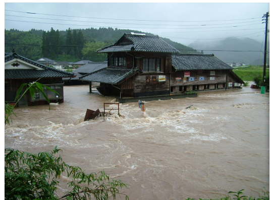
写真 4-9 (2) 湧水町浸水状況
