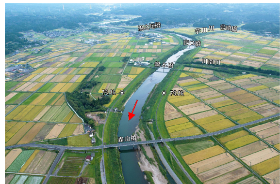
写真 2-1 (2) 森山橋付近 (73k 付近)
