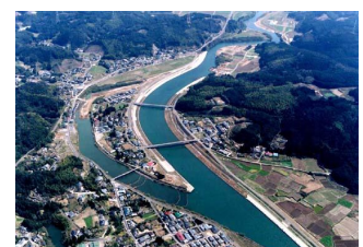
写真 4-17 湯之尾捷水路
