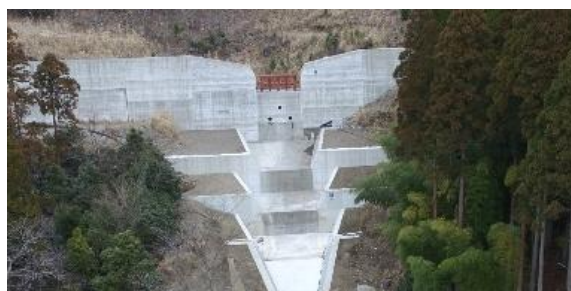
図 2-2 山腹工による土砂流出防止対策（宮崎県）
