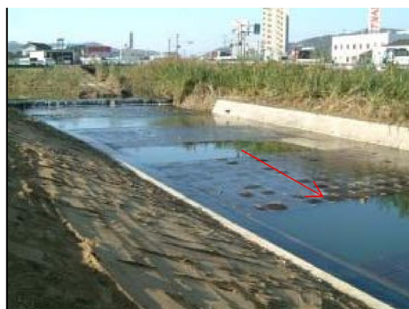
図 6-7 瀬戸川河川浄化施設の運用
