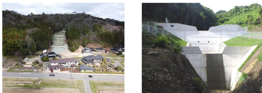
林野庁による治山施設整備状況
