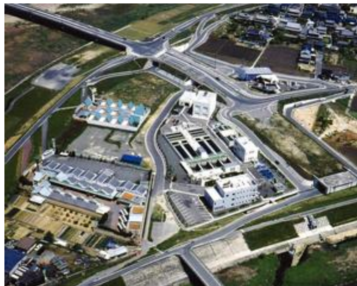
図 6-4 高屋川河川浄化施設
