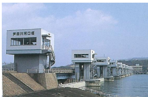
芦田川河口堰（昭和56年6月完成）
