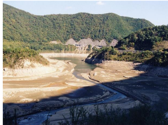
平成 14 年渇水（八田原ダム）
