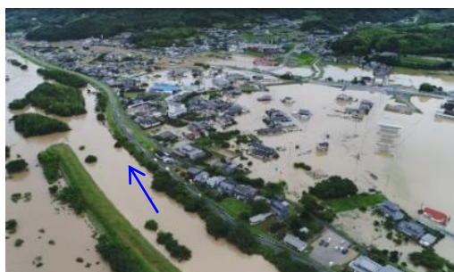
平成 30 年 7 月豪雨（福山市駅家町下山守付近）
