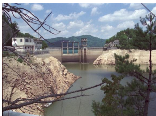
平成 6 年渇水（三川ダム）
