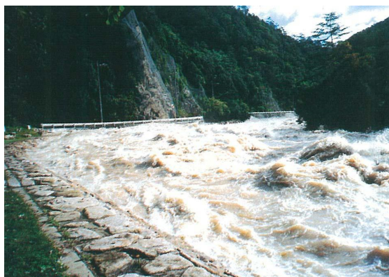
平成 10 年 10 月洪水（河佐峡付近：本川 42km）
