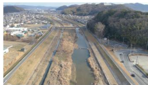
④高屋川 3.0k付近
