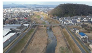
④高屋川 4.0k付近
