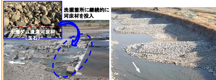
堰直下への玉石投入 (洗掘対策)
