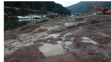
緩やかなアンジュレーションの中に自然な凹凸を付けた岩河岸 (山国川 上曾木地区左岸)
