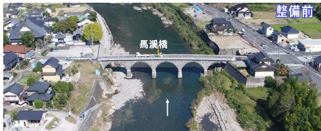
馬溪橋を存置した河川整備
