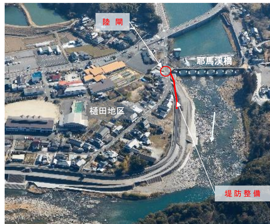
耶馬溪橋を存置した河川整備
