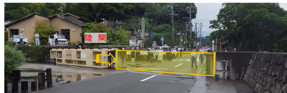
陸閘の整備(市道樋田横の手線)
