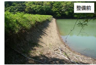
堤体の耐震化を行い、農業用ため池が有する洪水調節機能を強化
