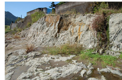
静的破砕剤(膨張剤)で岩を割ってブレーカーで粗く仕上げた岩河岸 (山国川 平田地区左岸)
