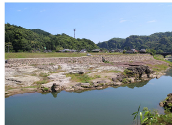
緩やかなアンジュレーションの中に自然な凹凸を付けた岩河岸 (山国川 上曾木地区左岸)
