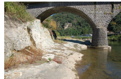
静的破砕剤(膨張剤)で岩を割ってブレーカーで粗く仕上げた岩河岸 (山国川 平田地区左岸)
