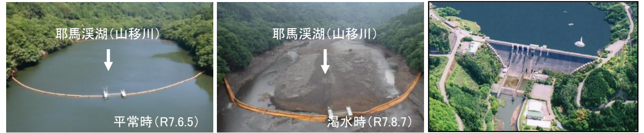
耶馬溪ダムの貯水池の状況(太平橋より上流を撮影)
