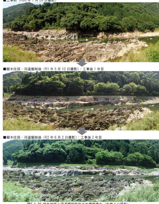
図3.1-10 樹木伐採と河道掘削前後での環境変化(右岸より撮影)
