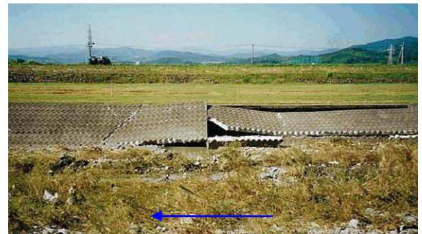
平成10年（1998年）9月洪水での統合堰下流の低水護岸の被災（香美市山田地先）
