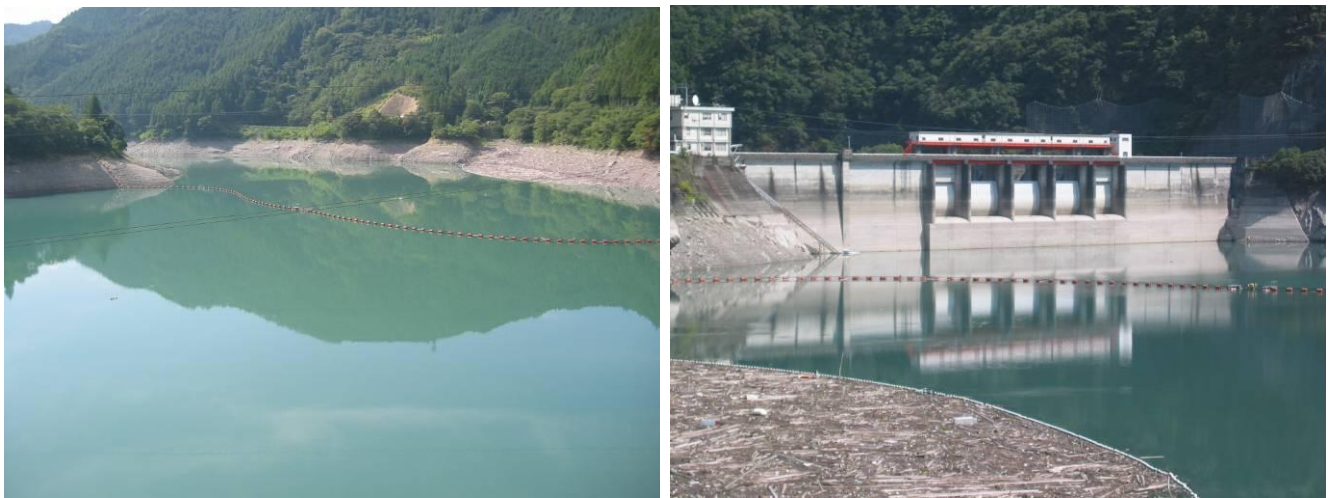
図 5-6 永瀬ダム渇水状況写真（平成 17 年(2005 年)8 月 17 日）
