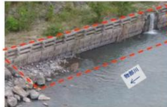
水制根固流失（箇所⑧）
