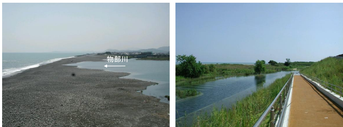
図 8-14 平成 13 年 8 月 23 日の河口閉塞による河口部右岸の親水施設の冠水状況
