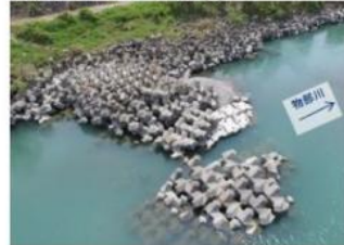
水制根固流失（箇所⑧）
