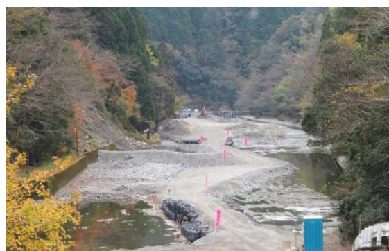
図 3.2.3 永瀬ダムにおける堆砂状況（左）及び堆積土砂の掘削状況（右）
