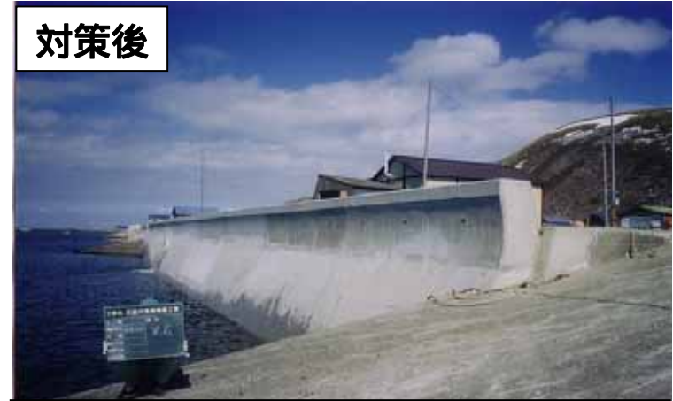
前腹付けによる老朽化対策後の護岸
