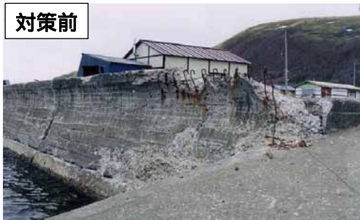
コンクリートの劣化等老朽化が進んだ護岸
