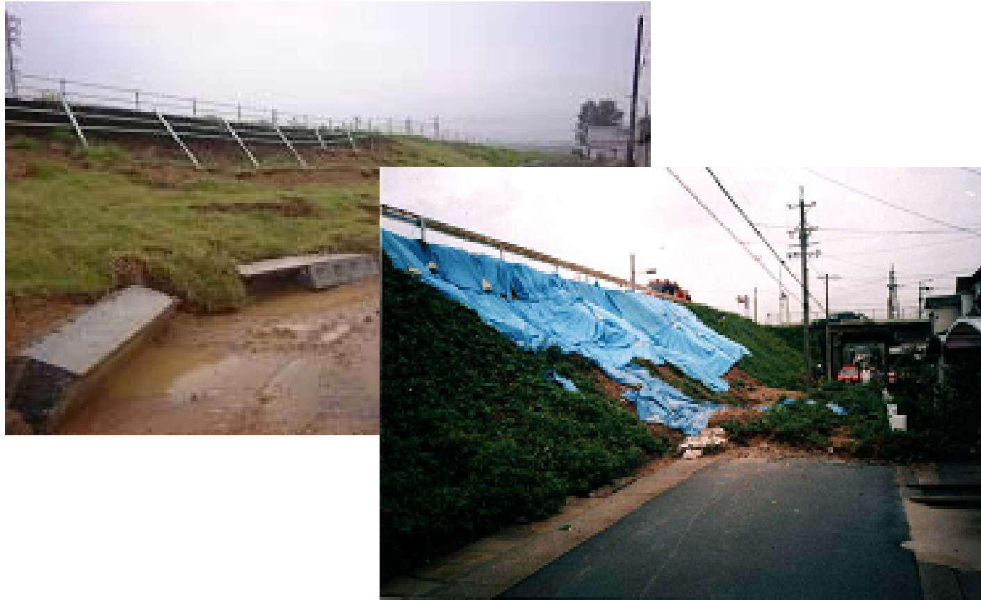
浸透に対する安全度不足のため法崩れ発生
