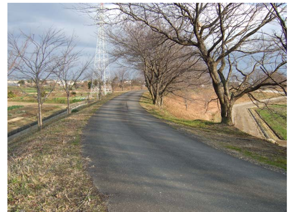
輪中堤の状況（福束輪中）
