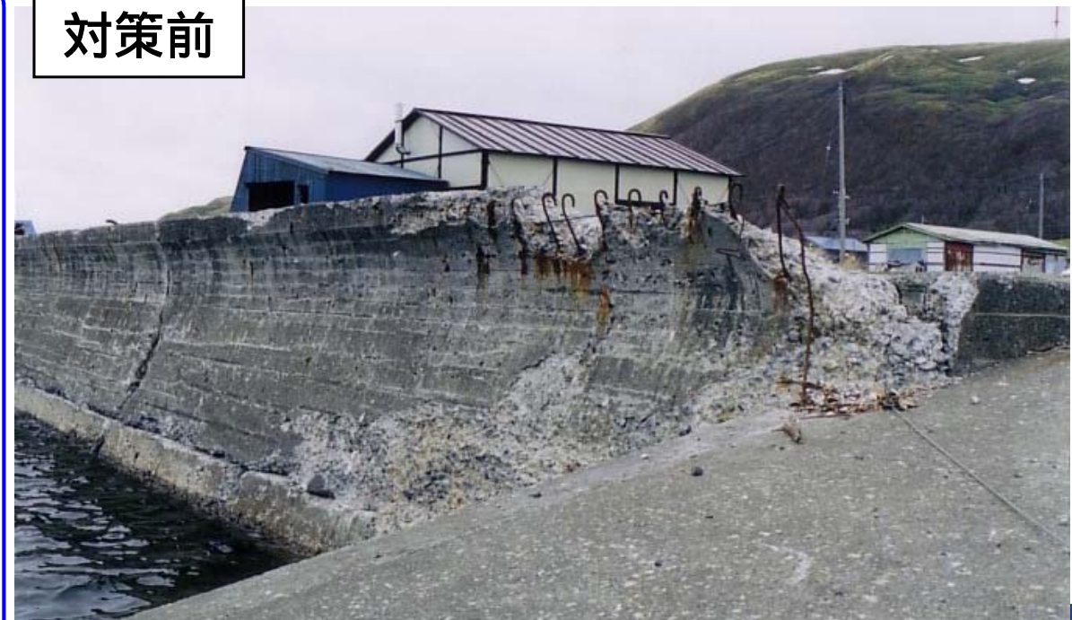
コンクリートの劣化等老朽化が進んだ護岸
