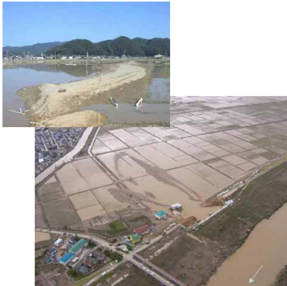
円山川(右岸13.2k付近) 平成16年台風23号
