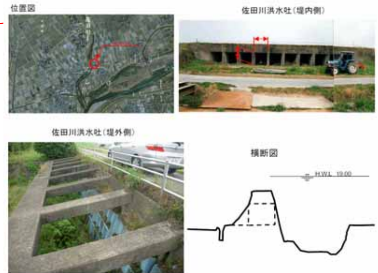
フラップゲートによる洪水吐き（佐田川洪水吐き）
