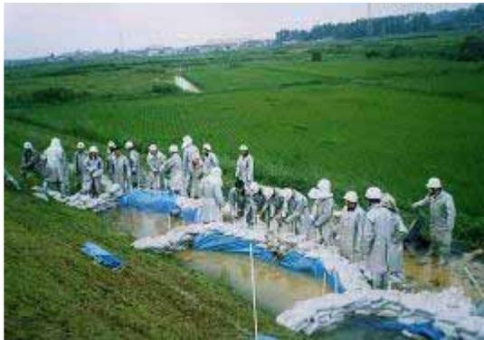
洪水時に堤体漏水が生じ、水防工法を実施
