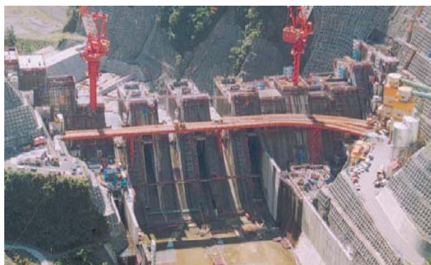
洪水調節施設の整備(ダム)
