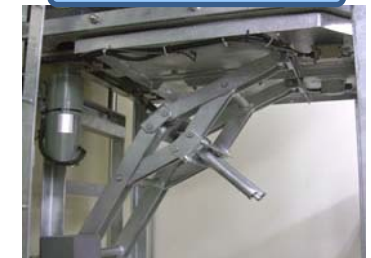
換気口浸水防止機
