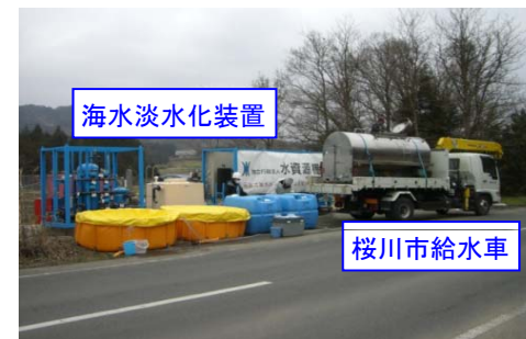
桜川市給水車への補給状況
