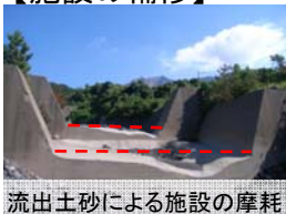
流出土砂による施設の摩耗
