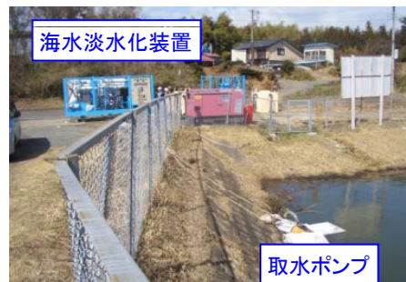
海水淡水化装置により農業用ため池の水を飲料水に浄化
