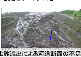
土砂流出による河道断面の不足
