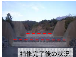
補修完了後の状況
