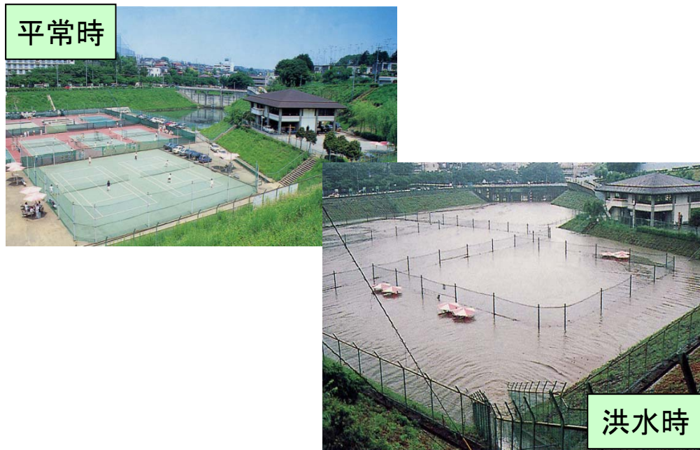
流域貯留浸透施設の整備事例
