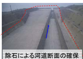
除石による河道断面の確保
