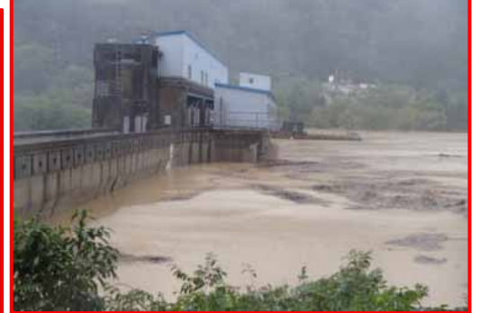
写真は平成25年9月 台風18号洪水の状況
