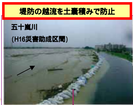
堤防の越流を土嚢積みで防止 五十嵐川 (H16災害助成区間)
