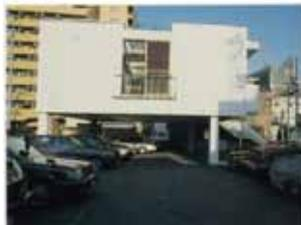
1階部分をピロティ(高床構造)とすることで浸水時の被害を軽減
