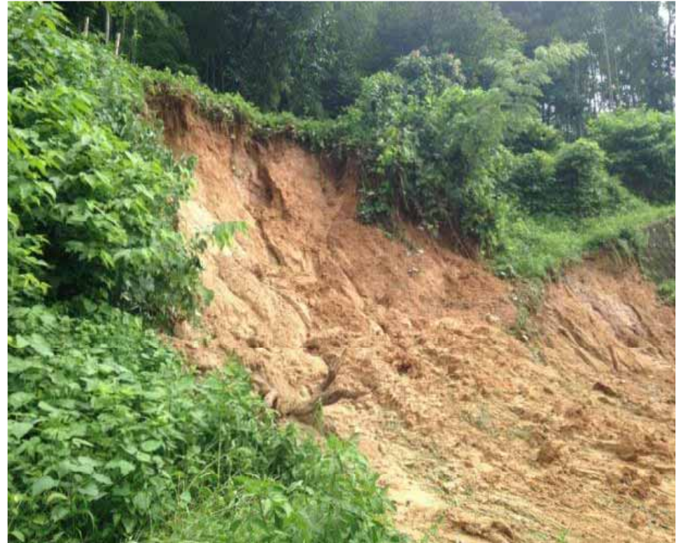
山本8丁目 崩壊地 上部
