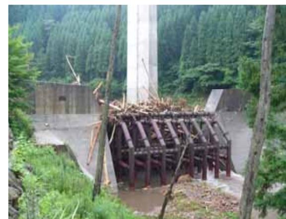
透過構造による流木捕捉(熊本県小国町)
