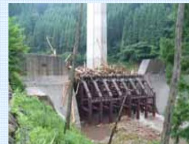
透過型砂防堰堤による土石流捕捉
