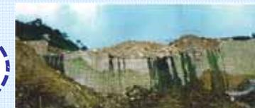
計画規模以上の土石流を受けたが倒壊せず減災効果を発揮した堰堤
