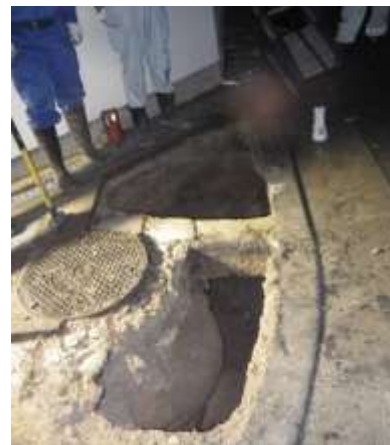
H25.9 下水管渠の老朽化を原因とした道路陥没(豊中市)
