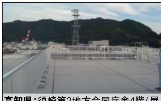
高知県：須崎第2地方合同庁舎4階(屋上)を指定
