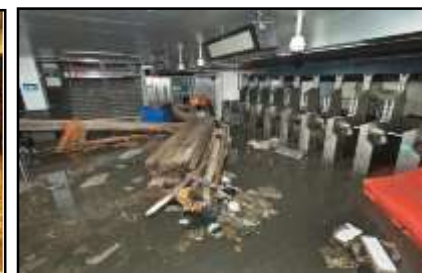
平成24年10月 ハリケーン・サンディ 地下鉄の浸水状況 ©MTA
