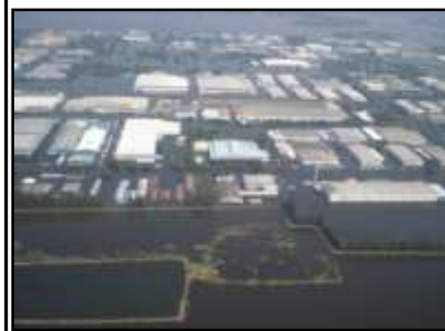
平成23年10月 タイ・チャオプラヤ川の氾濫によるロジヤナ工業団地浸水状況
